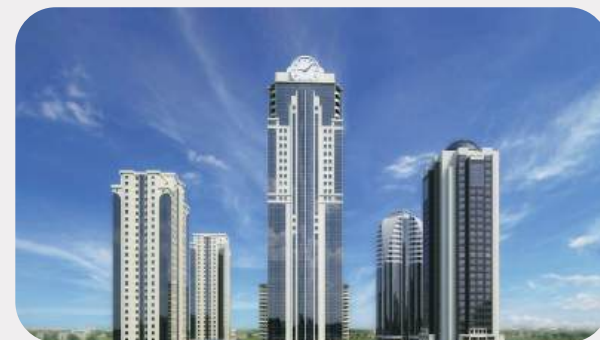
ЧР, г. Грозный, ул. Умара Димаева д. 14, 14 этаж. Офис RIM GROUP (комплекс «Грозный-Сити»)
