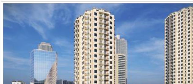
16-ти ЭТАЖНЫЙ ЖИЛОЙ ДОМ
