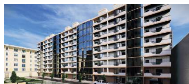
9-ти ЭТАЖНЫЙ ЖИЛОЙ ДОМ
