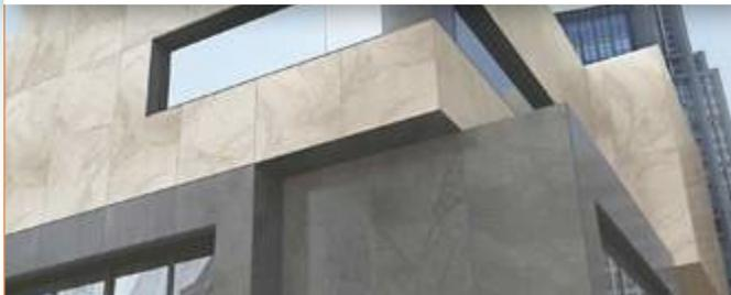
Керамогранит для фасада – бесприорышный вариант. Керамогранитные плиты изготавливаются во множестве вариантов цветов, рисунков и форматов. Фасадная керамогранитная плитка может быть неотличима от натурального камня, дерева, бетона или даже металла.
