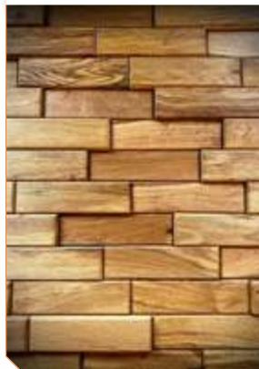
Кирпичи из дерева уже успели получить широкое распространение в строительстве загородных поселков категории «эко». Они уникальны отсутствием в своем составе синтетических и химических элементов, благодаря чему стены, возведенные из такого материала, пропускают воздух, не блокируют процесс циркуляции водяного пара, а также эффективно сохраняют тепло и делают проживание в доме комфортным и благоприятным.
