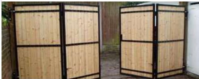
Складывающиеся ворота состоят из одной или двух створок, которые комплектуются из нескольких отдельных секций, соединенных между собой петлями. Секции при открывании компактно складываются «гармошкой», надежно фиксируясь по краям проема.
