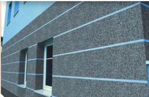
Минеральная штукатурка - цементная строительная смесь, так как связующим веществом в ней является именно портландцемент высокого качества, а также известь. Еще в составе обязательно имеются различные минералы-наполнители - это крошево гранита, кварца или мрамора. Благодаря такому сочетанию компонентов, получается очень надежный и качественный строительный материал, отлично подходящий как для внутренней, так и для внешней отделки зданий.
