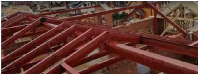
Металлические стропильные системы производятся из стального проката. Но для легких быстровозводимых зданий и сооружений (небольшие ангары, сцены, шатры, павильоны, овощехранилища и пр.) допускается применять стропила из алюминия.
