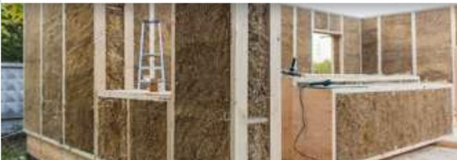
Акустические панели предназначены для обеспечения звукоизоляции. Между двумя внешними стенами вставлен звукопоглощающий материал, сама стена пористая. Таким образом, когда звук проходит через акустическую панель, интенсивность звука уменьшается.
