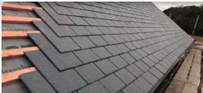
Асбестоцементный шифер — кровельный строительный материал, представляющий собой асбестоцементные листы плоской или волнистой формы.
