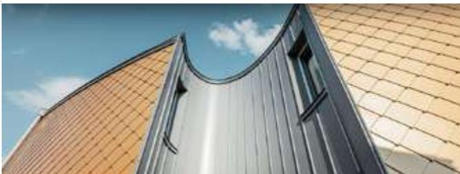
Фальцевая кровля — это металлические листы из оцинкованной стали, скрепленные фальцем (вид соединения, который достигается путем отгиба краев листа). Вдоль ската кровли делают стоячий фальц, а поперек — лежачий (это сделано, чтобы в стыки не попадала дождевая и талая вода).
