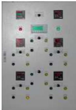
Шкаф управления холодным водоснабжением (ШУ ХВС) входит в систему управления подачей холодной воды в промышленные и жилые здания. В свою очередь, система ХВС может быть частью центрального теплового пункта или индивидуального теплового пункта (ЦТП или ИТП). Применение шкафов управления ХВС значительно улучшает эксплуатационные и экономические характеристики системы холодного водоснабжения зданий в целом.
