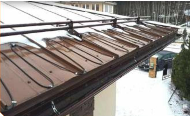
Система против обледенения крыш - это горизонтальный металлический карниз HotSheet или HotShingle (материал оцинкованная сталь или медь; алюминий по заказу), к которому подсоединен 12-ваттный саморегулирующийся нагревательный кабель коммерческого класса. Система HotEdge™ Rail крепится к фронту на металлические края на крыше, тем самым обеспечивается надежная защита нагревательного кабеля от влаги. Кабель в свою очередь передает тепло на край крыши и способствует быстрому его осушению.
