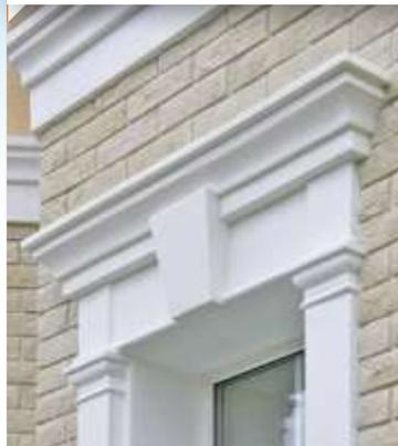
Фасадный декор — это элементы для украшения стен с наружной стороны дома. Пенополистирол с цементным покрытием. Состоит из пенопластовой заготовки, покрытой несколькими тонкими слоями плиточного клея, между которых сетка-серпянка. У плиточного клея морозостойкость F-50, то есть клей выдержит 50 раз частичного намокания, заморозки и разморозки.
