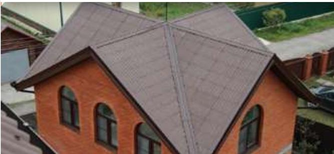
Многощипцовая крыша - несколько двускатных элементов, соединенных в общую конструкцию.
