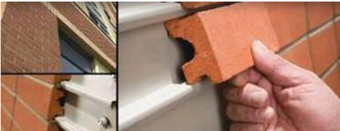
Суть новинки заключается в том, что специально изготовленные тонкие кирпичи монтируются на металлический каркас, прикрепленный к стене. Фиксация же кирпичиков происходит за счет специального клея или цементного раствора.
