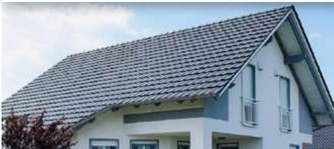
Двускатная – наиболее распространенная в силу удобства конструкции и простоты монтажа.
