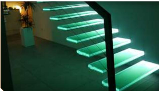
Парящие лестницы - это самонесущая, не имеет явной опоры (косоуров, как у маршевых конструкций, массивных стоек, как у винтовых). Ступени у нее со всех сторон открыты, их фиксирует невидимое крепление, скрытое в капитальной стене.
