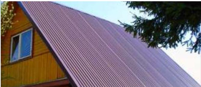
Профнастил – это современный материал с защитным покрытием. Стальные листы профилированы, благодаря чему обладают большим количеством положительных качеств.
