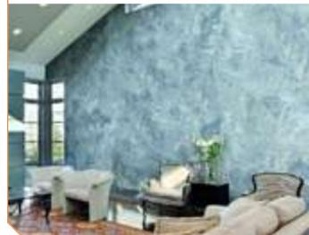
ет наполнитель, в качестве которого применяется известь, гипс или мраморная (иногда гранитная) мука. В результате получается полупрозрачная паста густой консистенции. Для получения нужного оттенка она колеруется.
