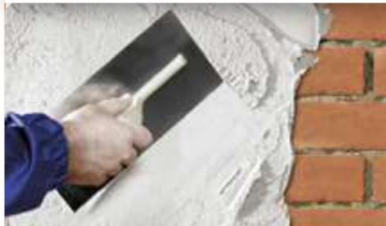
Выравнивающая - применяется на неровных стенах с большими перепадами. Может накладываться толстым слоем. Обычно имеет высокую зернистость.
