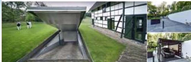
Подъемный механизм устанавливается в приямок устроенный ниже отметки пола гаража. Когда платформа находится в нижнем положении, приямок надежно закрыт несущей крышей, способной выдержать вес тяжелого внедорожника. Управление системой происходит при помощи кнопочного пульта, расположенного на стене, а для включения подъемной системы необходимо установить и повернуть специальный ключ.
