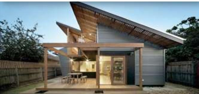
Односкатная – самая простая крыша. Это плоский элемент, наклоненный в одну сторону.
