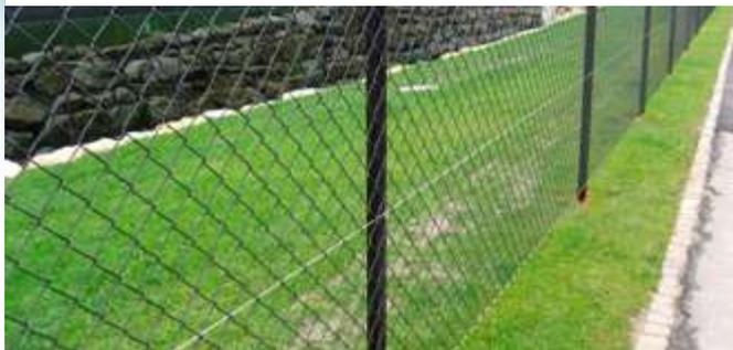
Забор из сетки-рабицы – сетчатое конструктивное полотно, полученное путем взаимного вкручивания проволочных спиралей.
