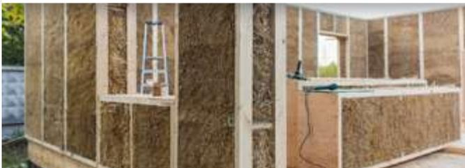
Основное применение фибролита — установка несъемной опалубки в строительстве. Фибролитовые плиты не удаляются, как некоторые другие виды опалубки, а остаются конструктивной частью или стены или любого перекрытия.
