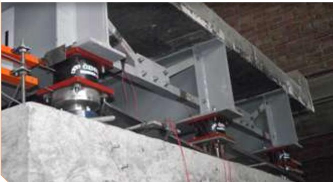
Сейсмический демпфер - устройство, встроенное в конструкцию здания или иной технической объект, предназначенный для снижения амплитуды его механических колебаний. Применение демпферов в сооружениях позволяет снизить дискомфорт людей от колебания здания, а также предотвратить его повреждение или разрушение в случае землетрясений и ураганов. Как правило, такие демпферы представляют собой бетонные или стальные блоки, соединённые с конструкцией здания с помощью пружин или тросов.
