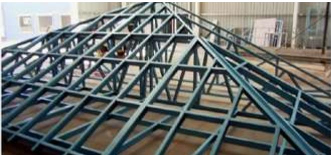
Стропильная система – это каркас крыши. Она выполняет несущую функцию. Конструкцию изготавливают из дерева, реже из металла.
