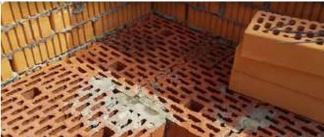
Керамический блок или керамический камень — это искусственный керамический камень сложной формы, предназначенный для кладки стен, перегородок, перекрытий.
