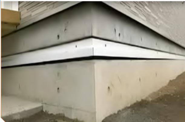
«Парящий» фундамент — это японская технология, которая позволяет зданиям буквально парить в воздухе и защищает конструкцию в случае землетрясения.
