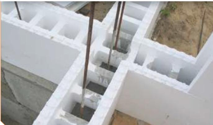
Несъемная опалубка — это панели или блоки, выполненные из различных материалов, которые монтируют в единую конструкцию. Это своеобразная форма, предназначенная для укладки монолитного бетона. Она помогает упростить и ускорить строительство благодаря объединению в один технологический цикл нескольких операций. После схватывания бетона несъемная опалубка превращается в функциональную часть конструкции готовых стен.
