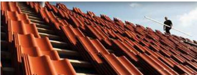
Керамическая черепица – штучный натуральный материал, изготовленный из обожженной глины. Процесс производства заключается в подготовке сырья, формовании глиняной заготовки, сушке и последующем обжиге при температуре в пределах 1000 °С.
