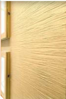
Декоративная – является альтернативой обоев, окрашивания и других вариантов отделки. Может использоваться как внутри, так и снаружи зданий. Есть масса вариантов нанесения и создания фактуры. При этом не нужно до идеала выравнивать основу. Декоративная штукатурка ложится на базовую и тоже скрывает мелкие дефекты. После застывания поверхность становится прочной, износостойкой, влагостойкой. Это простой и в то же время надежный вариант финишной отделки стен.
