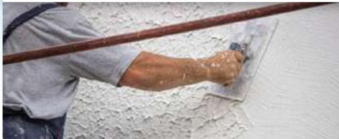
Структурными компонентами являются: каменная крошка (щебневидная или обкатанная), синтетические/керамические гранулы, обломки ракушек, различного происхождения волокна, металлическая пыль и др.
